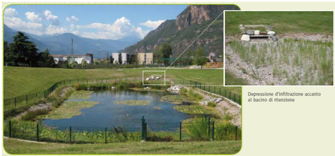
Figura 33. Bacino di ritenzione con infiltrazione artificiale
