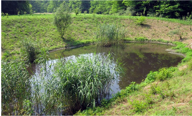
Figura 34. Bacino di infiltrazione e fitodepurazione
