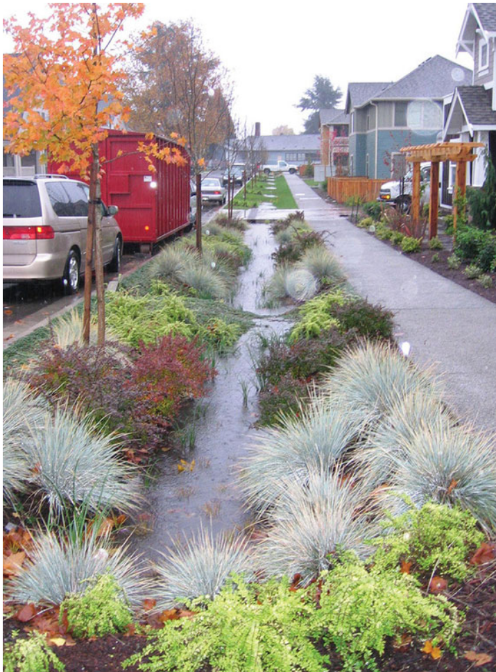
Figura 36. Bioswale parallelo alla strada. Può essere laterale o centrale, tra i due sensi di marcia
