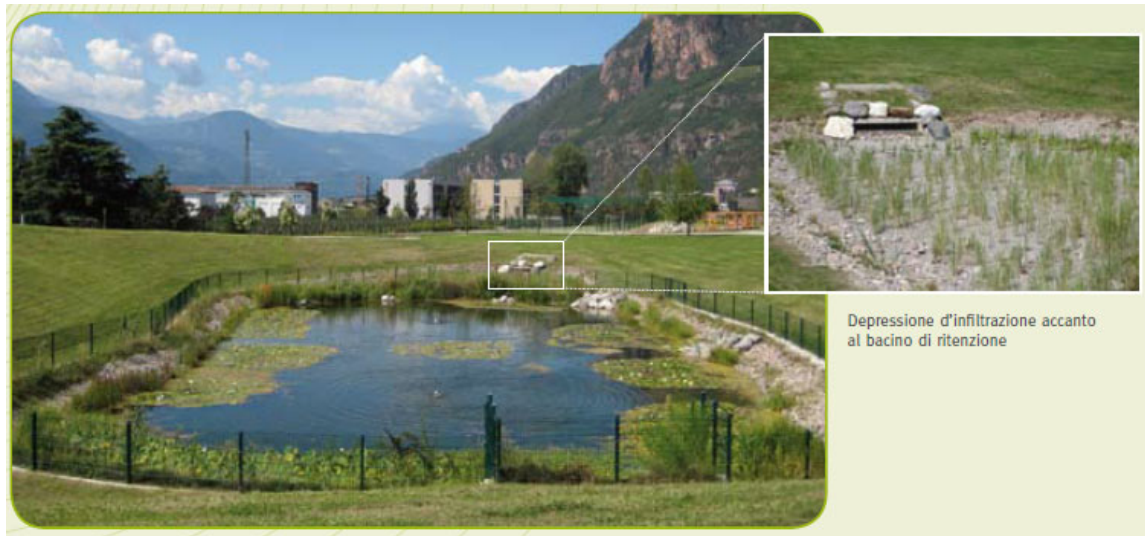
Figura 33. Bacino di ritenzione con infiltrazione artificiale
