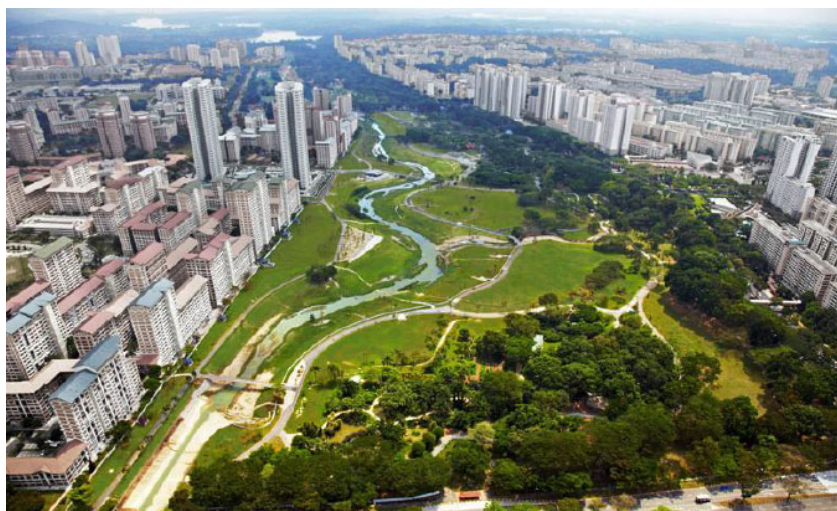
Figura 30. Rinaturalizzazione del Kallang River (Bishan Park), Singapore
